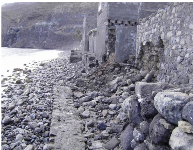
Foto 5 – Degradação devido a acção das ondas do mar
